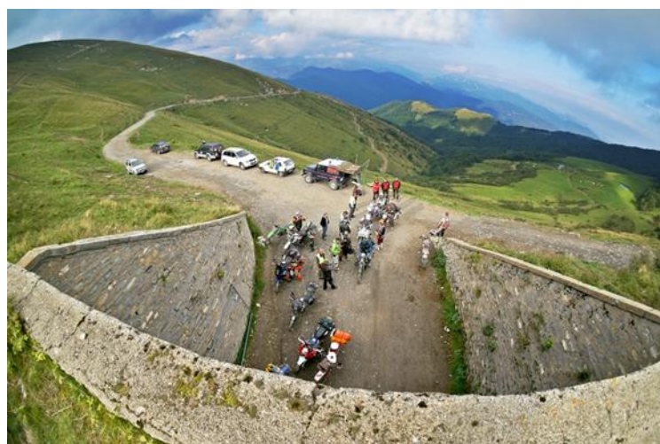
87° km. La galleria di Colle Garezzo, 1.700 m, dove si trova il primo controllo a timbro.
